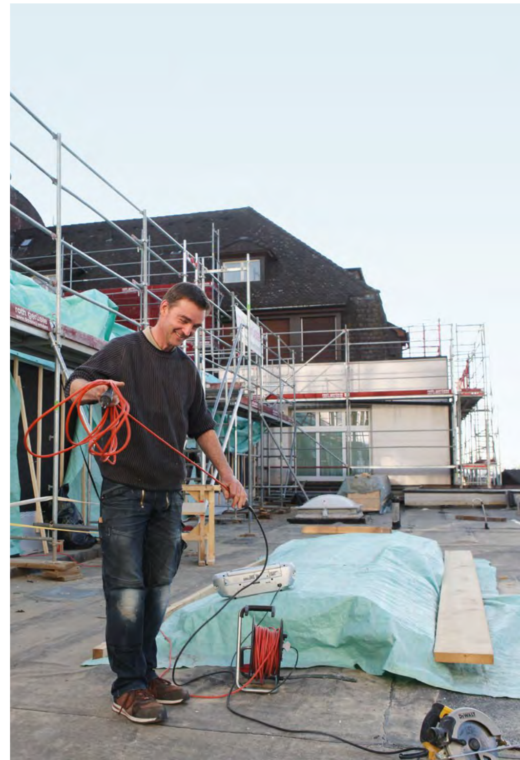
Die Gesamt-sanierung in Rheinfelden schreitet gut voran.
